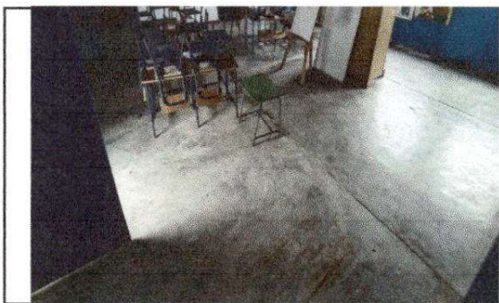
FOTO 11; Sustrución de piso cerámico
