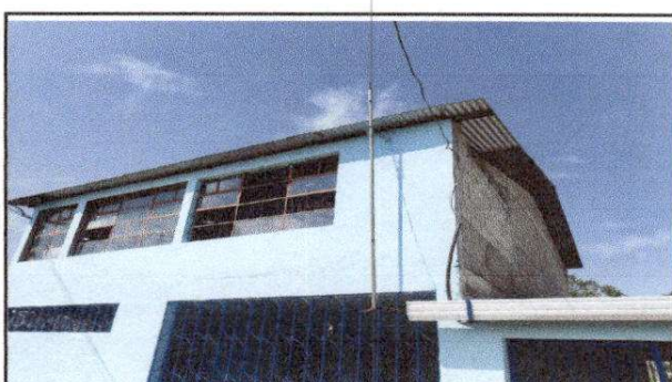
FOTO 10: Sustrución de canal de metal
