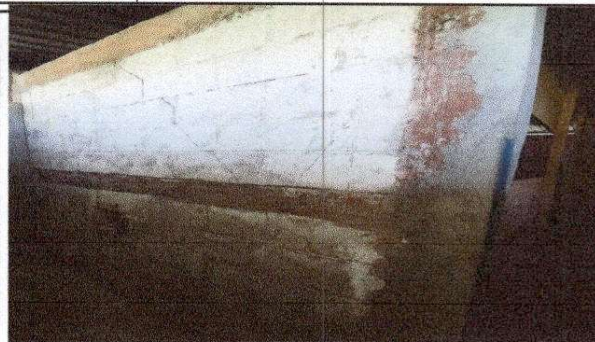
FOTO 2: pintura en muros exteriores e interiores
