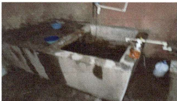
FOTO 9: Sustrución de pila de cemento de dos lavadero
