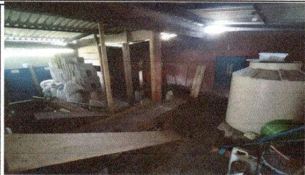
FOTO 1: Sustitución de piso de ceramico
