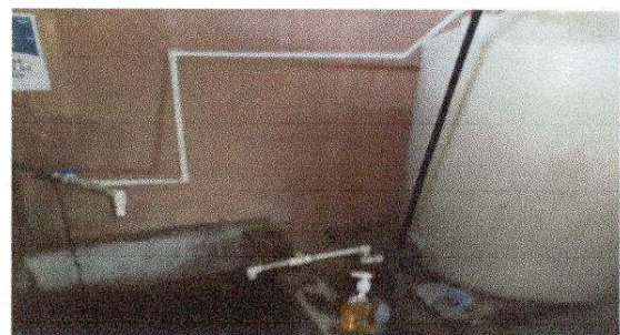
FOTO 5: Instalación de tubería principal de pvc
